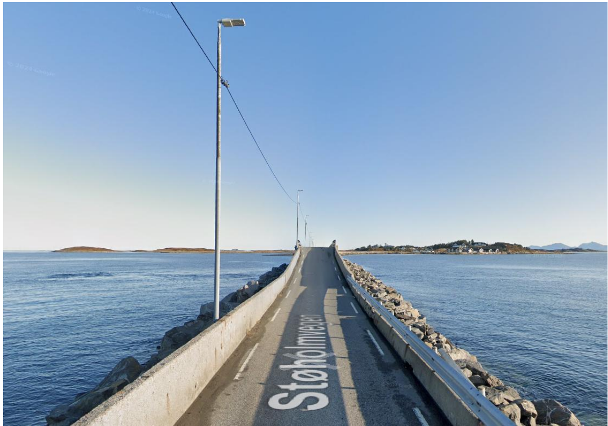
Figur 8 – Bildet viser hvordan sikten er mot dagens bru. Kilde: Google
