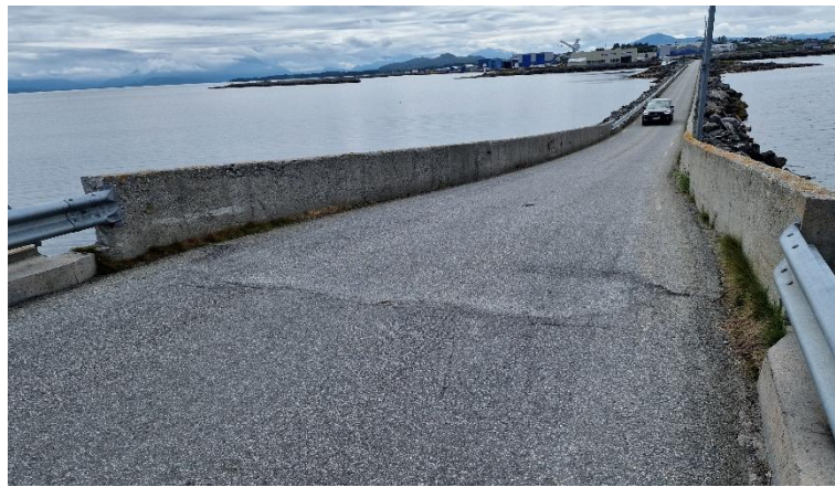
Figur 6 – Eksisterende Finnøybru - sett fra toppen av dekket
