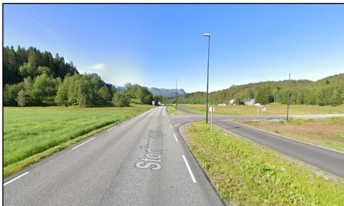
Figur 2: Fv. 650 ved kryssområdet, Nytt kryss til høyre (vegbilder juni 2019)
