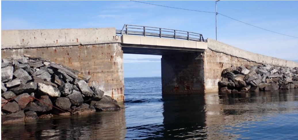
Figur 5.3.1.2: Foto av dagens Finnøy bru, frå 2025. Kjelde: Møre og Romsdal fylkeskommune
