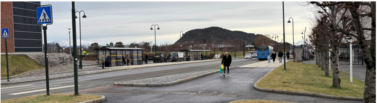
Figur 11. Det nye gatestoppet på Moa, sett mot øst.
